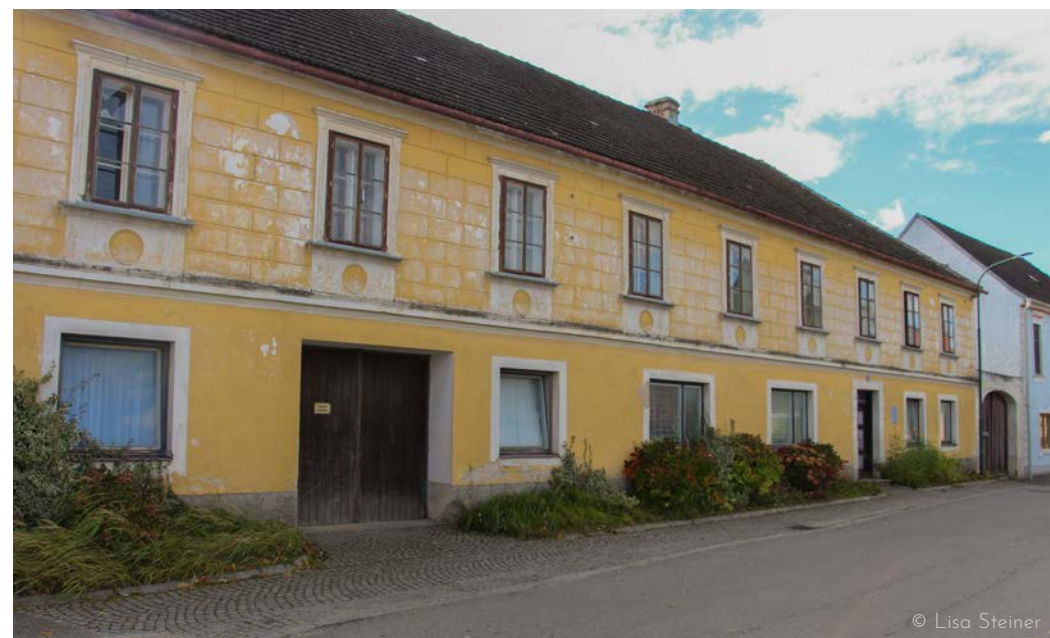
Die Textilfabrik Hirschbach im derzeitigen Zustand
