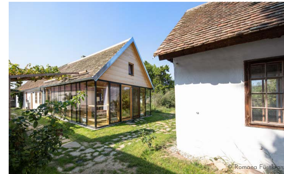
Ein schmaler, ehemaliger Bauernhof wurde behutsam zu einem zeitgemäßen Wohnhaus umgebaut.
