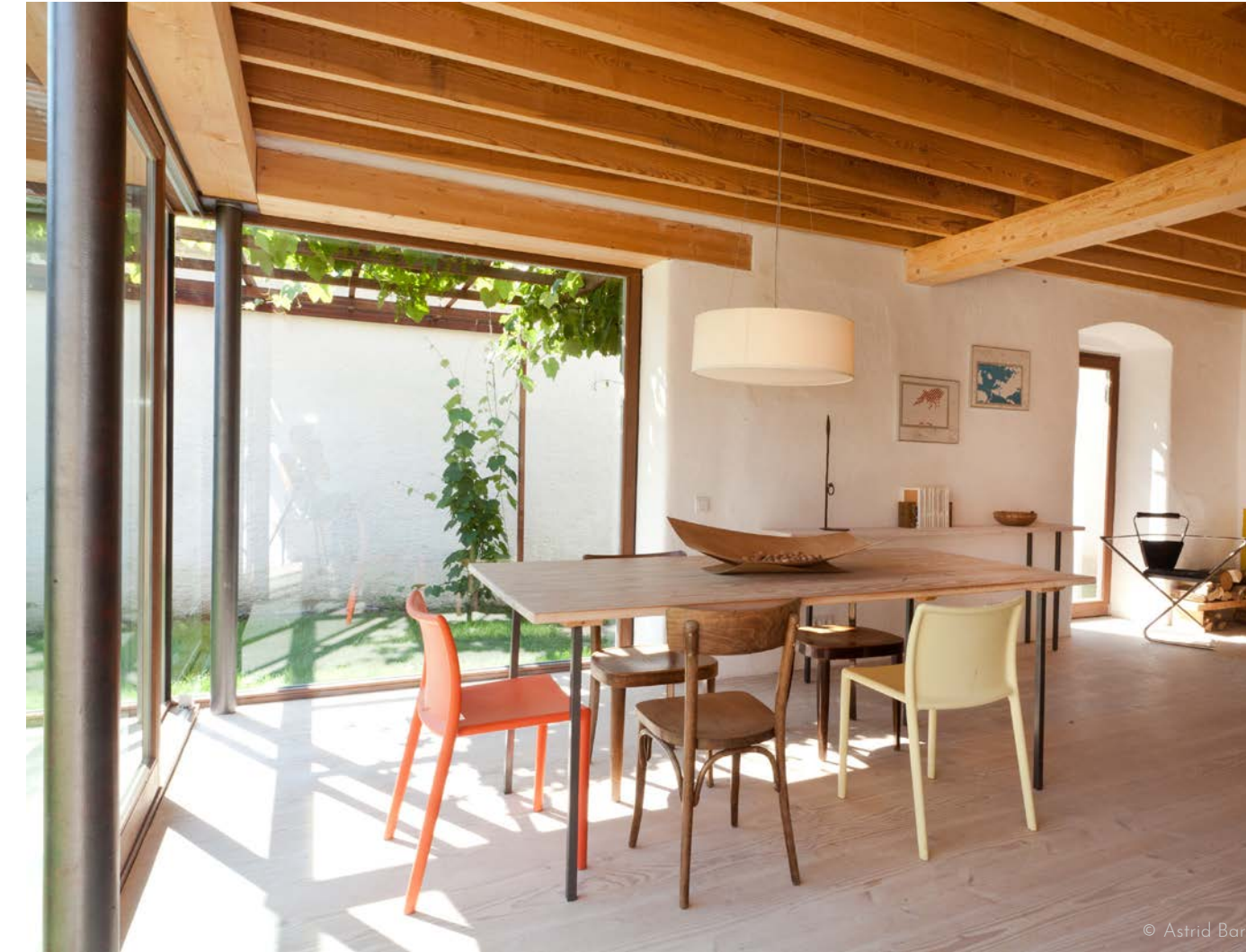
Das 1850 erbaute Lehmhaus nach behutsamer Transformation: höhere und hellere Räume durch das Absenken des Bodens bzw. durch den Abbruch der Parapete.
